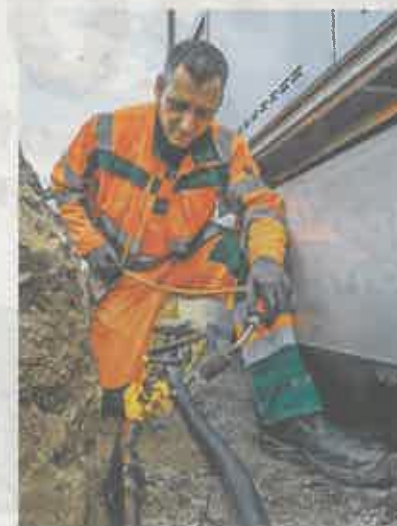
Der Elektriker Udo Ertel von der Humuswirtschaft Kaditz GmbH bereitet mit vielen anderen Kollegen die neuen Schaltanlagen vor, damit die Telekom die Technik einbauen und in
